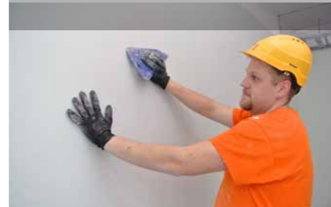
Tomi Karhu on asentanut uudet matalaprofiiliset lasikuitutapetit tulevaan potilashuoneeseen.
